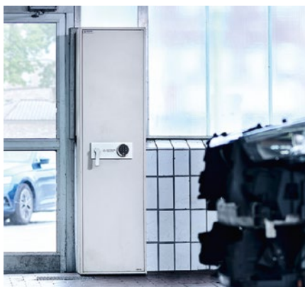
Der Tresor ist sicher vor fremdem Zugriff im Inneren der Werkstatt installiert.
