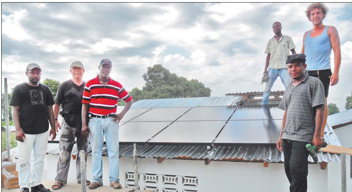
Willi Ernst (Zweiter von links) auf der Baustelle des Berufsschulzentrums in Haiti. Dort wollte er eigentlich eine große Solaranlage aufbauen. Die aber steckt seit Monaten beim Zoll fest. Foto: WV
