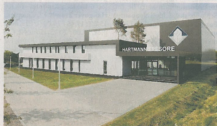
Das neue Domizil: Die Zentrale liegt an der Pamplona-Straße 2 im Ge-werbegebiet Mönkeloh. FOTO: HARTMANN
