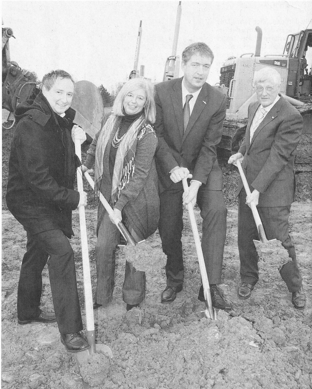
Beim ersten Spatenstich: Architekt Christian Decker, die stellvertretende Vorstandsvorsitzende und der Vorstandsvorsitzende von Hartmann Tresore, Elvira Weidemann und Christoph Hartmann, sowie Paderborns Bürgermeister Heinz Paus (v. l.) auf der Baustelle an der Pamplonastraße.
